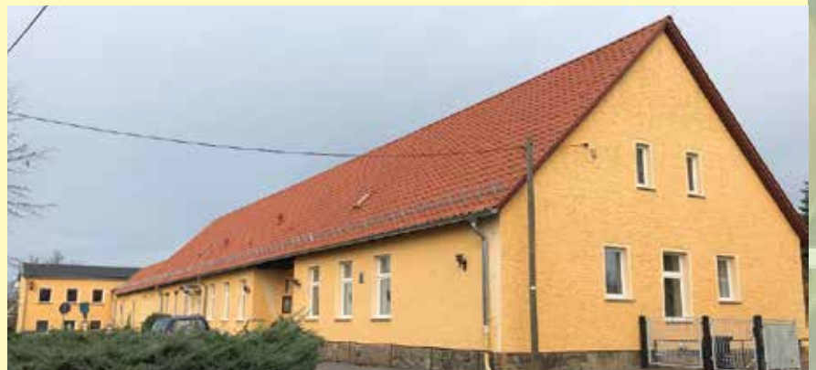
Ansicht Ärztehaus Falkenhagen mit erneuerter Dacheindeckung, Foto © pro³
